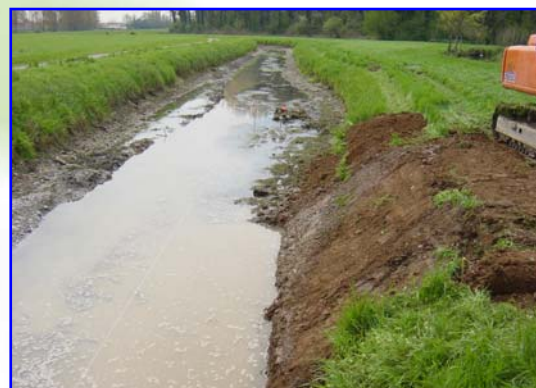
Foto 1 – Iniziale Uferneuprofilierungsphase
