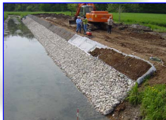
Foto 2 – Einbauphase, differenzierte Füllung der Taschen mit Steinen und Vegetationsboden
