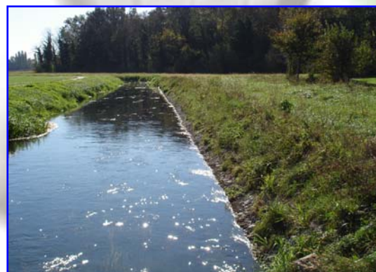
Foto 3 – Begrüntes Bauwerk 5 Monate nach Beendigung der Arbeiten
